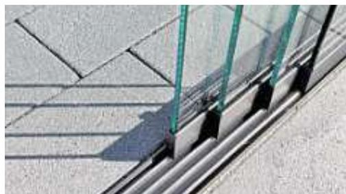
Mit System: Die Schiebetüren aus Sicherheitsglas laufen auf Schienen, die im Pflaster eingelassen sind.
